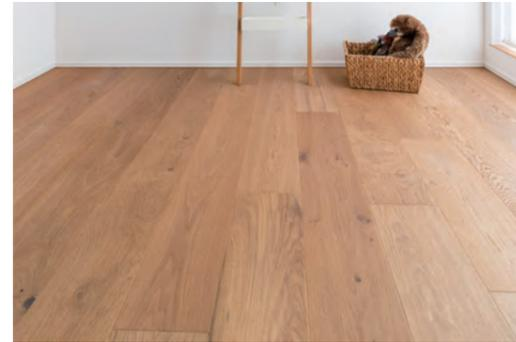
●**ユニ**…縦方向に複数の木材を継ぎ足して定尺に揃えた商品のこと。一枚の長さが長くなるため、施工効率が上がります。
