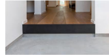
上框は玄関や勝手口などの段差がある個所で主に土間から床に上がる部分のこと。室内の床材・床下地などの切断面を隠す役割を果たしています。
