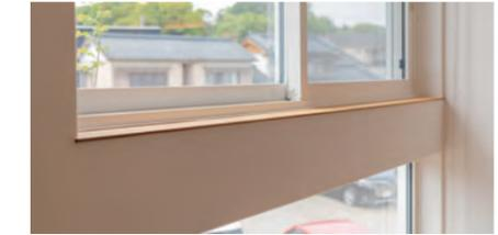
サッシを納めるための部屋内側の枠のこと。インテリアをすっきりと魅せるため、ie-mon の窓枠は三方に窓枠を設けない下枠だけの仕様となっています。
